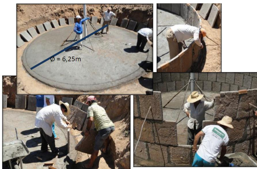
Figura 10: Construção da parede da cisterna
