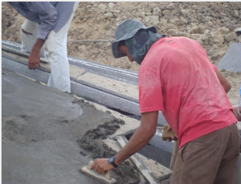
Figura 15: Colocação das placas de cobertura
