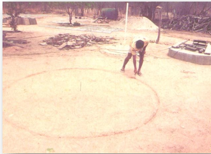
Figura 3: Marcação da área da cisterna
