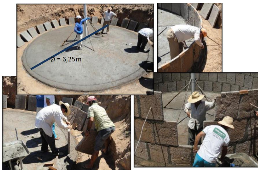
Figura 10: Construção da parede da cisterna
