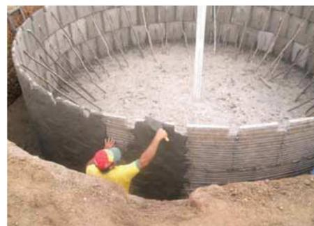
torno da coluna central, onde foram retirados os 10 centímetros do cano, também deve ser feito um rodapé arredondado.
