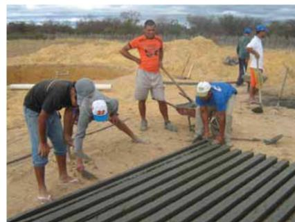
de 3/8, conhecido também por ferro de 10 milímetros, com 3 metros e 10 centímetros de comprimento. São usadas três réguas de 3 metros e 10 centímetros.
