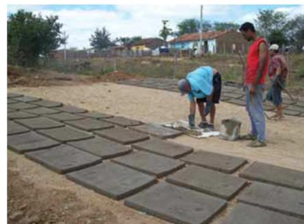
Em seguida, a forma é tirada e repete-se a ação. É melhor trabalhar com duas formas para adiantar o serviço. Para garantir uma placa resistente, é necessário molhá-la duas a três vezes, durante dois a três dias, com um regador, para que água caia por igual em cima da placa inteira.
