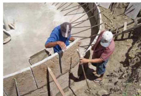
Ao todo são 111 placas da parede. Elas medem 50 por 60 centímetros. Trinta e sete placas são cortadas para o encaixe dos caibros ou vigas (corte de 8 por 6 centímetros). Duas placas têm um buraco de 100 milímetros, sendo um para a entrada de água que vem do calçadão e o outro para a saída de água quando a cisterna estiver cheia. Elas ficam na terceira fileira de placas, na mesma altura e na parte mais alta da placa, para aumentar a capacidade de armazenamento da cisterna.
