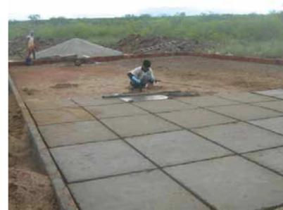
Cada traço da massa leva 4 carros de areia, 1 saco de cimento e 1 carro de brita. As placas terão entre elas um rejunte com massa de cimento de 1 centímetro de largura. As placas devem ser confeccionadas no próprio local.
