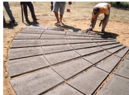
As placas do teto são compostas por 37 conjuntos com 4 peças. Para fazê-las, o primeiro passo é nivelar o chão. Depois, as formas são colocadas na área nivelada e preenchidas com massa. Essa ação deve ser repetida até completar 37 conjuntos. É sempre bom fazer um conjunto a mais (de reserva), pois alguma peça pode se quebrar. É importante molhar as placas de cobertura duas ou três vezes ao dia.
