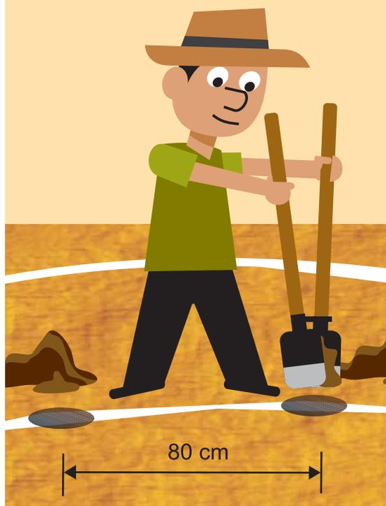
Depois cavamos os 8 buracos de 50 cm de profundidade para fixar todas as estacas. As estacas devem ter altura de 1,80 m acima do solo.
