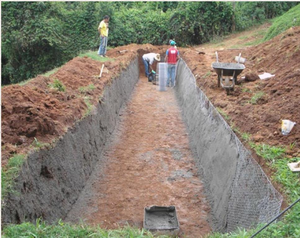
ao longo da cava e fazer o reboco (2cm) sobre a mesma. A argamassa da parede deve ser de 2 partes de areia (lavada média) por 1 parte de cimento. A argamassa do piso deve ser de 3 partes de areia (lavada) por 1 parte de cimento, com espessura de 2 cm. Pode-se usar uma camada de concreto embaixo do piso, caso o solo não seja muito firme.
