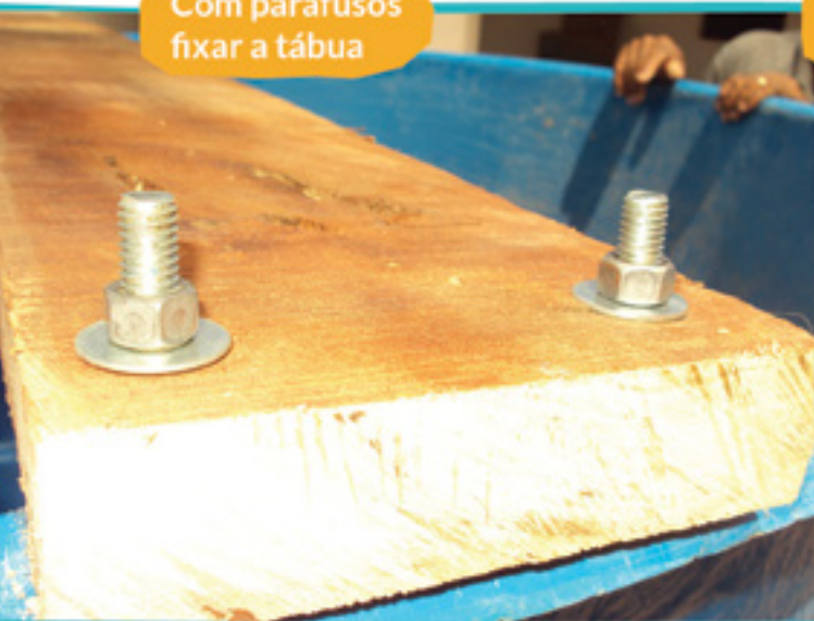
Fixação da tábua na caixa de fibra
